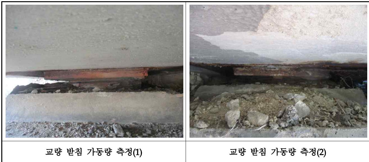
【사진 3.12】 교량받침 이동량 측정
