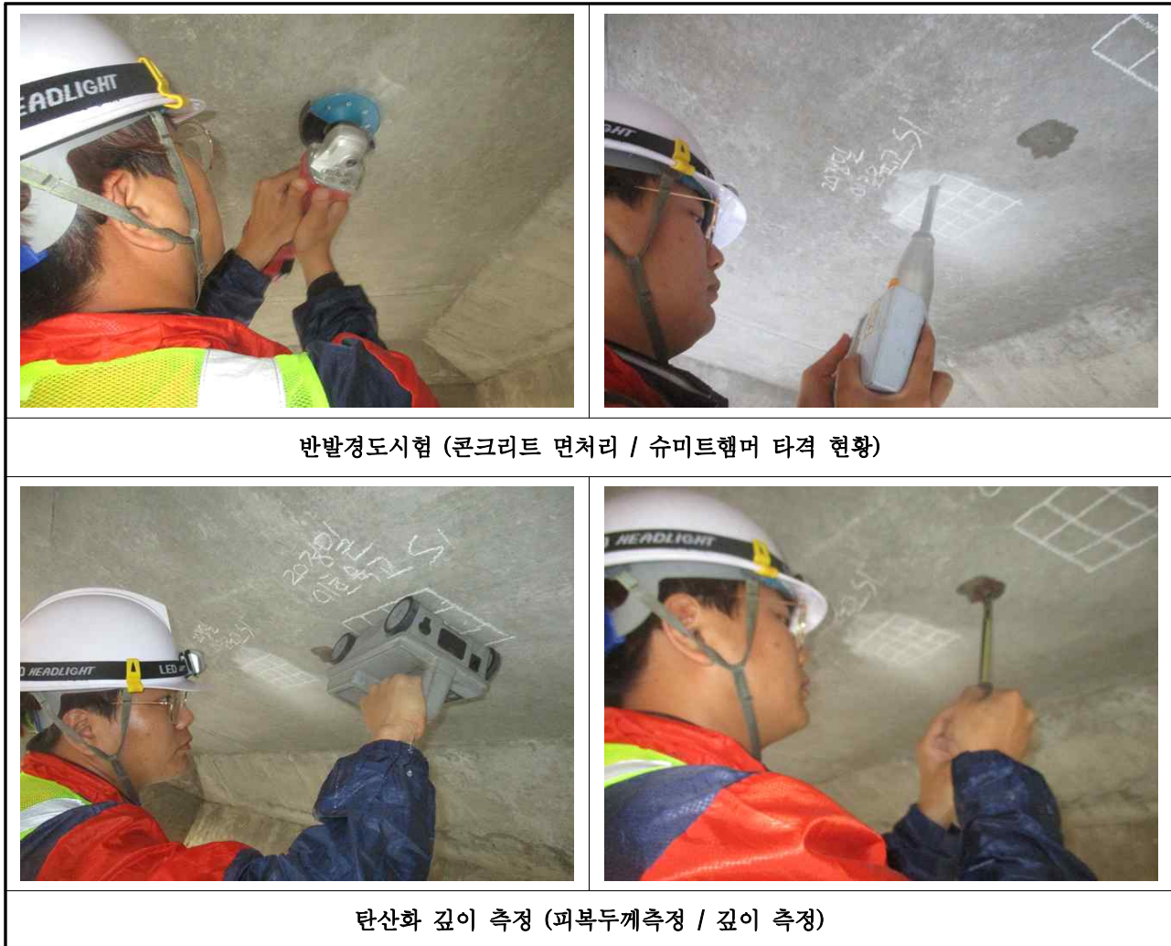
【사진 3.22】 콘크리트 내구성조사 현황
