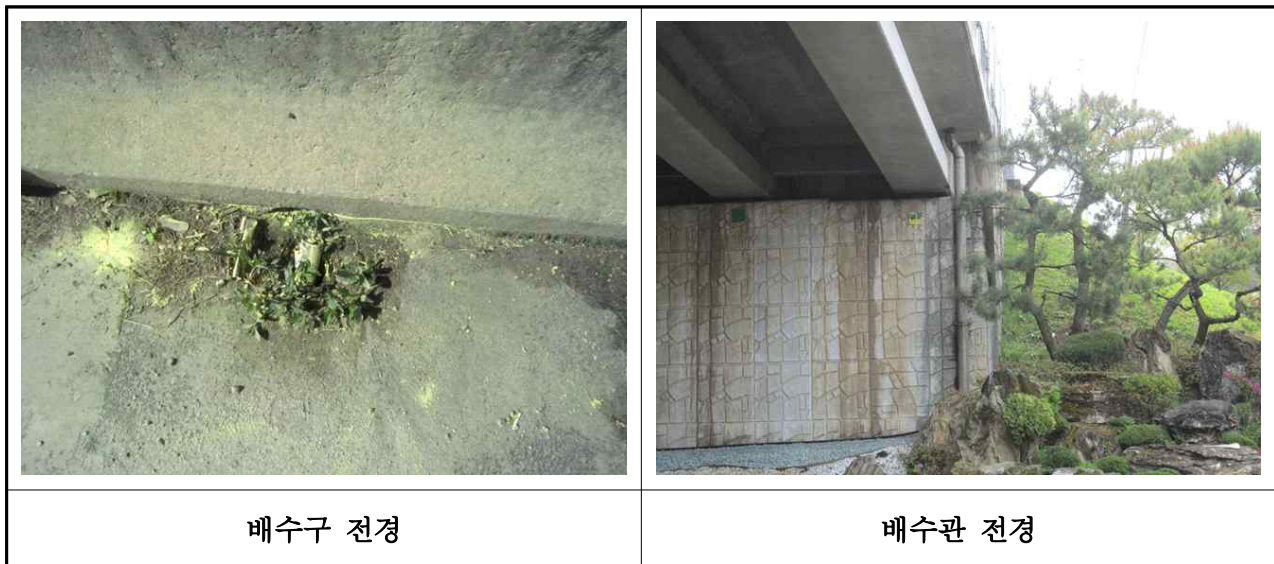
【사진 3.18】 배수시설 전경
