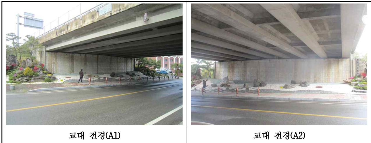
【사진 3.7】 교대 전경
