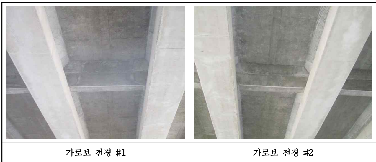
【사진 3.5】 가로보 전경
