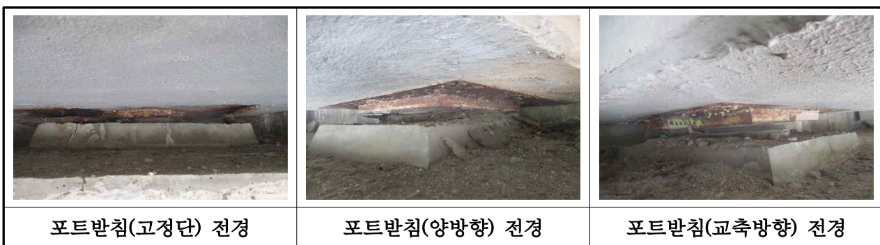
【사진 3.9】 교량받침 전경
